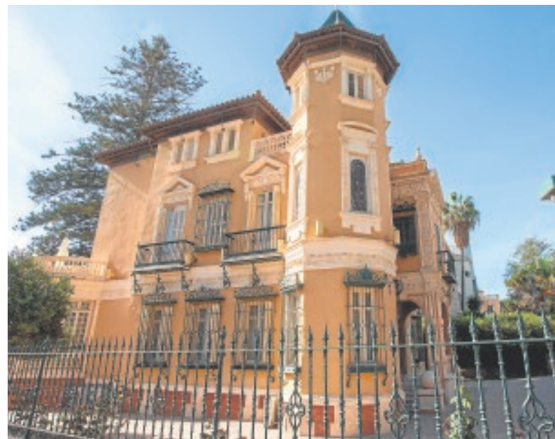
El palacete Villa Onieva, un edificio protegido, nueva sede de Roca Junyent-Gaona, Palacios y Rozados en Málaga // ABC
